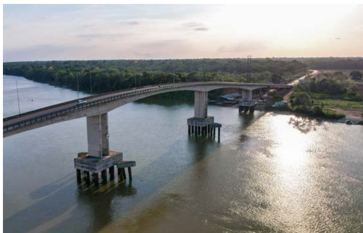
Ponte Rio Matapi
