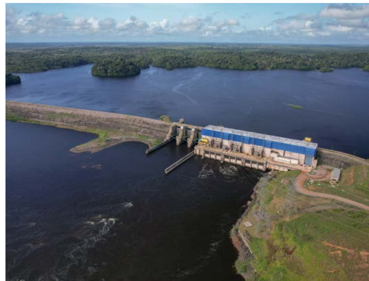
Usina hidrelétrica Ferreira Gomes
